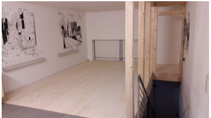
Kurz vor Weihnachten: Die Zimmereiarbeiten sind fertig. Jetzt konnten die aufwändigen Arbeiten in Eigenleistung beginnen: Elektroinstallationen, Lampen einbauen, Wände bauen, Anstreichen, Acrylarbeiten, Türen einsetzen, Treppe einbauen, Boden verlegen und zum Schluss dann noch Schränke und Regale aufstellen, bevor in Kürze endlich unser Archiv hier einziehen kann.
