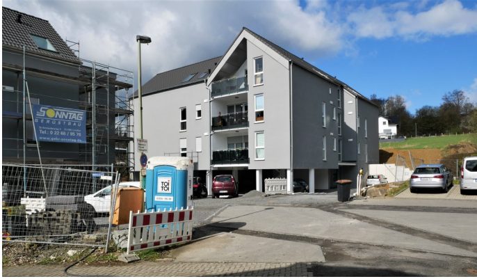
Die 2 neuen Häuser „Im Sonnengarten“ mit ca. 24 Wohnungen sind fast fertig und schon teilweise bezogen.
