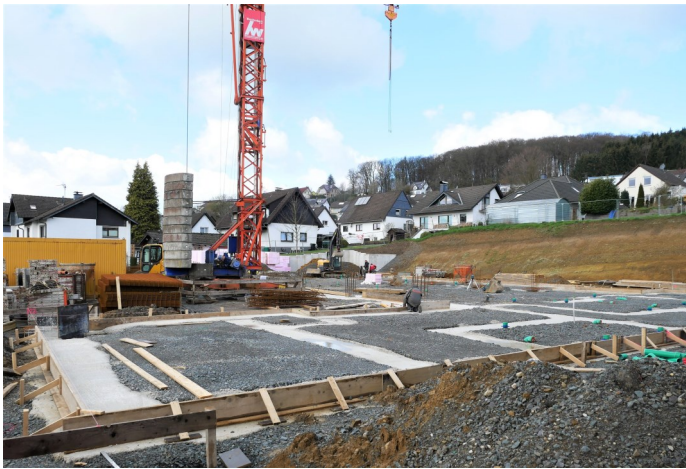
Beim neuen Feuerwehrgerätehaus sind die Fundamente gegossen. Die Ausmaße lassen sich schon erahnen.
