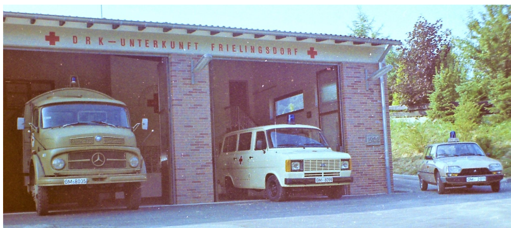
Die heutige DRK-Unterkunft wurde größtenteils in Eigenleistung durch die DRK-Bereitschaft Frielingsdorf gebaut. Von außen erkennt man nur die zwei großen Tore der Fahrzeughalle. Im rückwärtigen Bereich sind unten Sanitär- und Funktionsräume und oben ein Schulungsraum integriert. Im Laufe der Jahre wurden hinter und neben der Unterkunft mehrere Garagen und ein Carport ergänzt.
