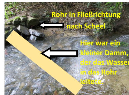
Die Bachweiche ist so konstruiert, dass ein kleiner Damm das Wasser durch das Rohr in Richtung Scheel führt. Den Damm hatte das Hochwasser weggespült. Der Rohrdurchlass dient auch als Mengenbegrenzung. Nur wenn die Wassermenge größer wird, fließt sie über den Damm und durch den Bachlauf östlich der Straße „Zur Zwergenhöhle“ in den Scheelbach.
