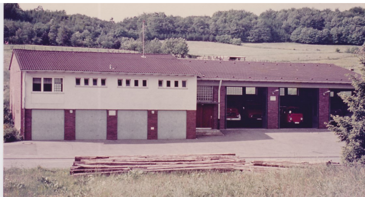
Das Foto zeigt die angebaute Wagenhalle, an die das DRK später seine Unterkunft anbaute.
