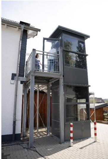
Die erste und auffälligste Veränderung ist sicherlich der Aufzug, der bereits vor einem Jahr an der Außenwand angebracht wurde und seitdem einen barrierefreien Zugang zum Saal in der oberen Etage sichert.
