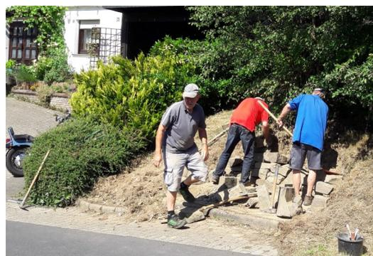
*Bei der Bank an der Neuenbergstraße wurden die maroden Holz-Palisaden gegen Grauwacke ausgetauscht.*
