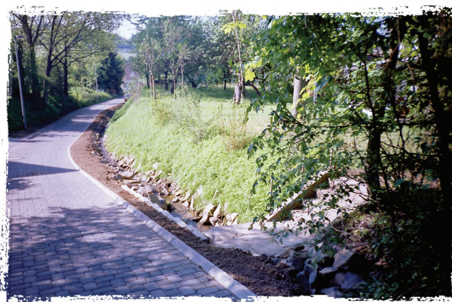
Der Dörner Siefen verlief früher auf halber Höhe an der Böschung entlang in undichten Beton-Halbschalen. Durch den Umbau wurde er ein „echter Bach“ neben dem neu gestalteten Pflasterweg.
